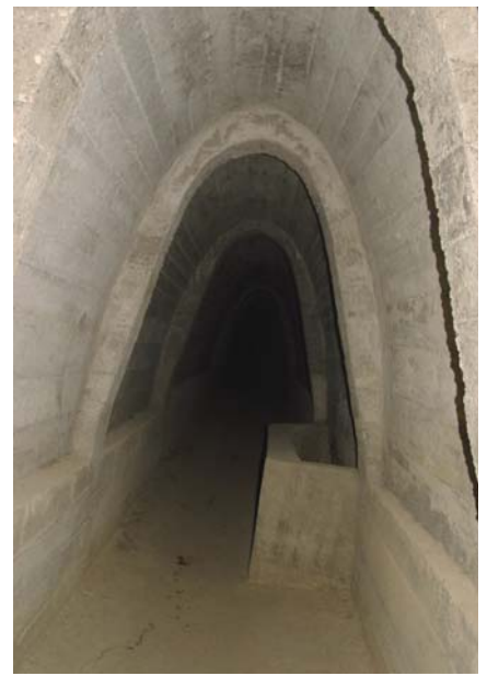
54. Az eredetileg téglaboltíves, később szakaszonként vasbetonnal "bélelt" forrásalagutak különböző járatai
