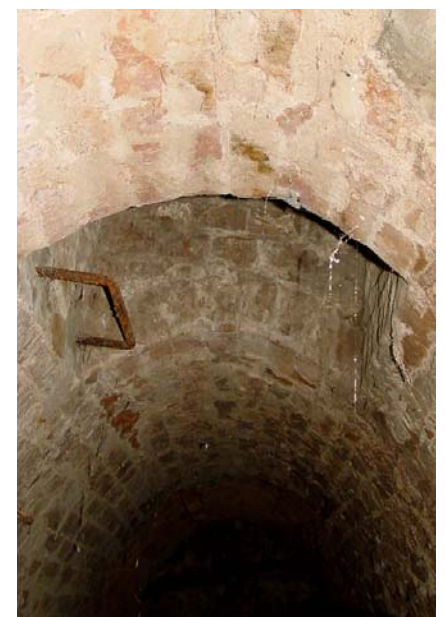
55. A fürdőházhoz vezető alagút megerősített leágazása, annak vége és az innen nyíló kijárat akna helye
