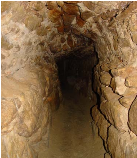
56. A Bajcsy-Zsilinszky u. alatti kettős áteresztés és kis-belmagasságú (cca. 70 cm) alagútjai
