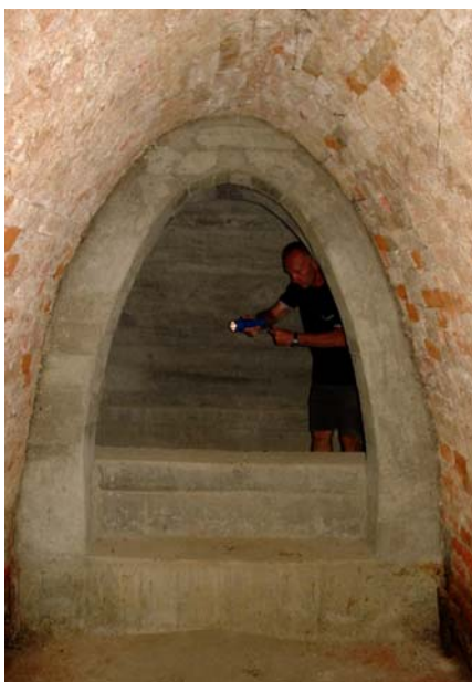
55. A fürdőházhoz vezető alagút megerősített leágazása, annak vége és az innen nyíló kijárat akna helye
