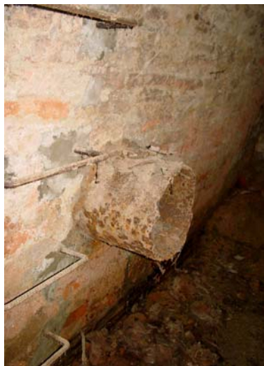
57. Vörösfenyő talpgerendák, a nyitott medencéhez egykor vezetett víz csőcsomója és egy forrásfoglalási hely
