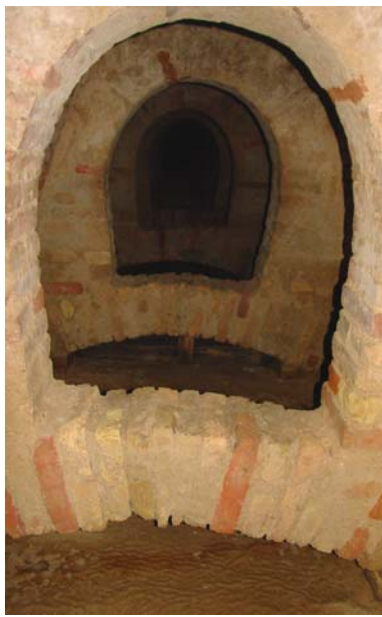
54. Az eredetileg téglaboltíves, később szakaszonként vasbetonnal "bélelt" forrásalagutak különböző járatai
