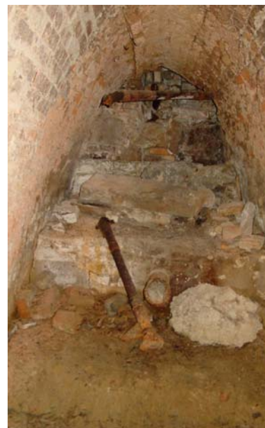
55. A fürdőházhoz vezető alagút megerősített leágazása, annak vége és az innen nyíló kijárat akna helye
