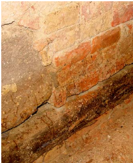
57. Vörösfenyő talpgerendák, a nyitott medencéhez egykor vezetett víz csőcsomója és egy forrásfoglalási hely
