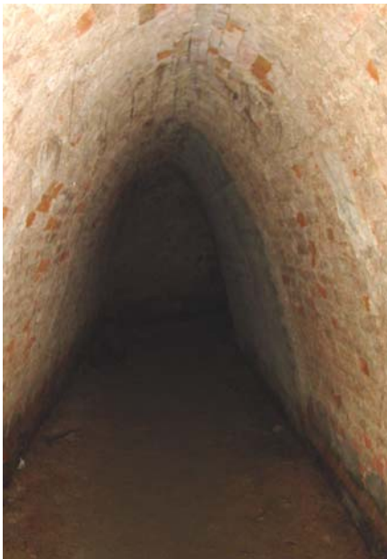
54. Az eredetileg téglaboltíves, később szakaszonként vasbetonnal "bélelt" forrásalagutak különböző járatai
