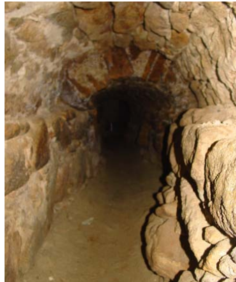
56. A Bajcsy-Zsilinszky u. alatti kettős áteresztés és kis-belmagasságú (cca. 70 cm) alagútjai
