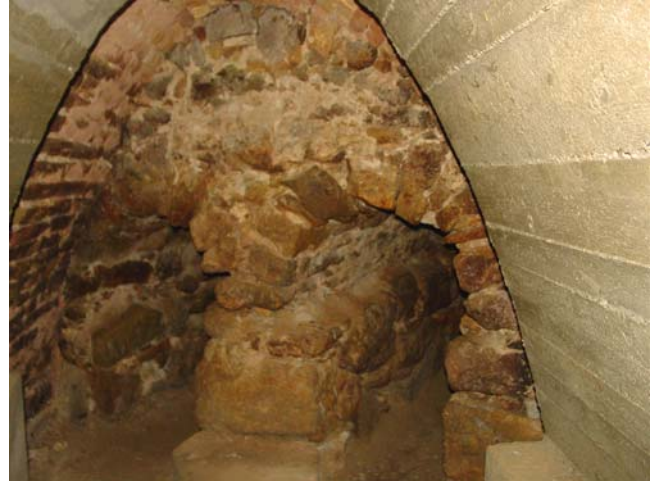
56. A Bajcsy-Zsilinszky u. alatti kettős áteresztés és kis-belmagasságú (cca. 70 cm) alagútjai
