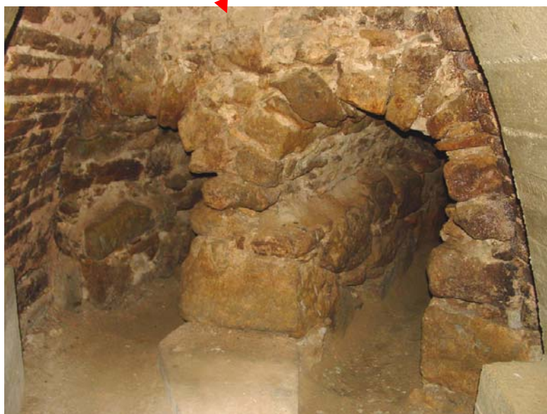
51. A Bajcsy-Zsilinszky u. alatt átvezetett kettős kő átérés
